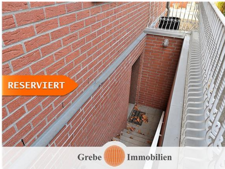
Seitlicher Kellereingang mit Überdachung
